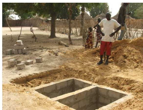
La fosse des toilettes publiques
